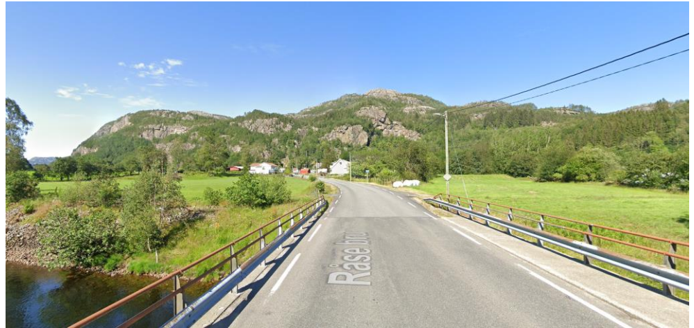
Figur 14: Foto av dagens situasjon. Råse bru sett fra dagens E39 (Kilde: Googlemaps)
