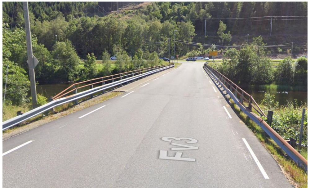
Figur 35: Foto av Råse bru og dagens rekkverk. (Kilde: Googlemaps)
